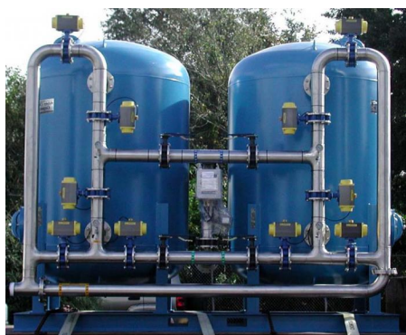
Рис. 1.4. Фільтр механічної очистки води: 1, 8 – патрубок; 2 – розподільник рідини; 3 – корпус; 4 – завантаження; 5 – центральний колектор; 6 – гравій; 7 – перфоровані промені [25, 68]
