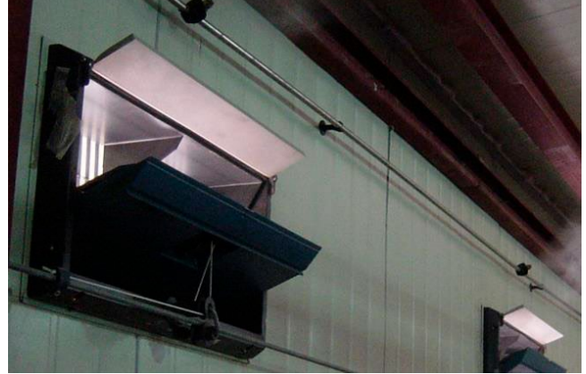
Рисунок 1.6 – Форсунки зрошування для кондиціонування повітря влітку [50, 51]
