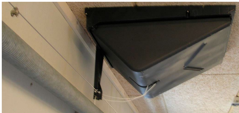
Рисунок 1.10 – Перфорована стеля з додатковими припливними клапанами
