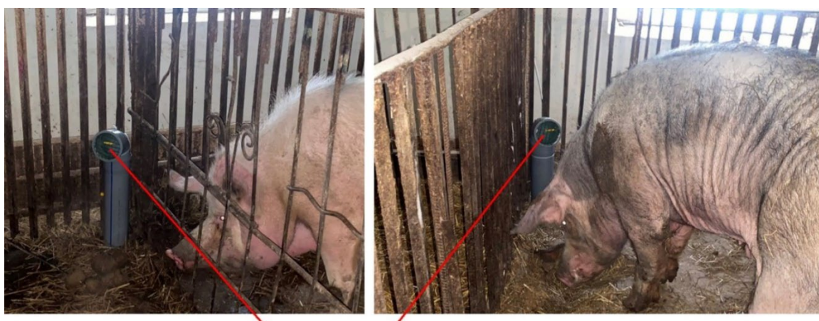
Повітропроводи вентиляційної системи подачі повітря
