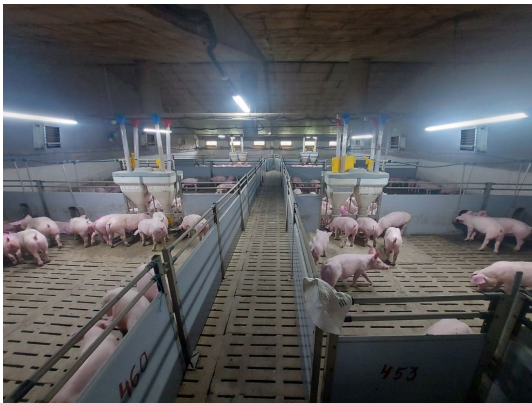
Загальний вигляд приміщення для утримання свиней
